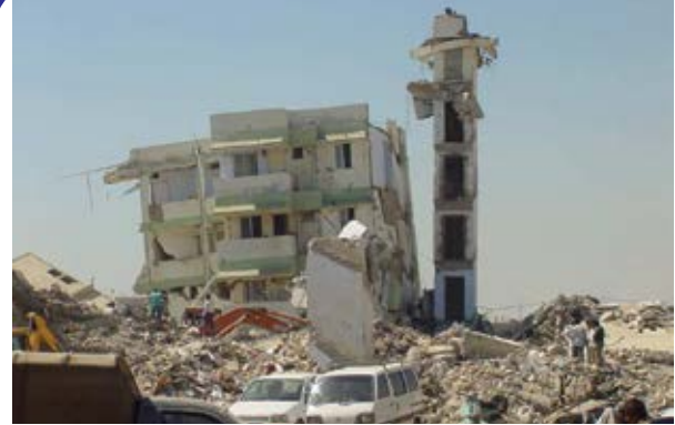
चित्र २५.४ : ढलान र ठाडा संरचनात्मक अङ्गहरुको कमसल जोडाईको परिणाम - सन् २००९ मा भारतमा गएको भूज भूकम्पको बेलामा ढलेको ढलान घर।
