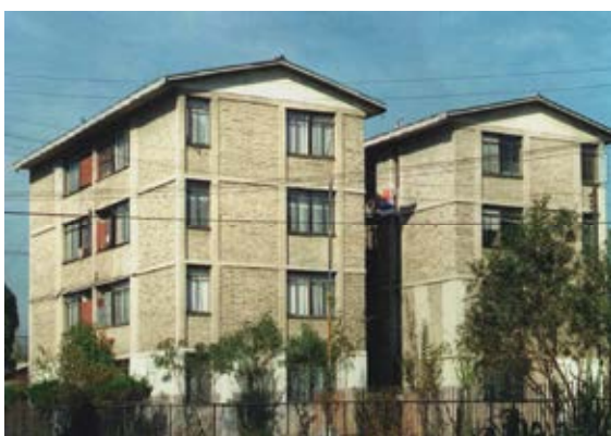
चित्र २८.१ : बाँधिएको गारो प्रयोग गरिने भवन निर्माण प्रविधि चित्र (क) प्रमुख अवयवहरु चित्र (ख) चिलीमा बनाईको ४ तल्लो घर
