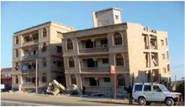
चित्र २१.३ : आरसीसी भवनमा खुल्ला भुईँतल्ला- भुईँतल्लाको पिलरमा धेरै क्षति पुग्न गई भवन पूर्ण रुपमा अतिक्रमण ।
