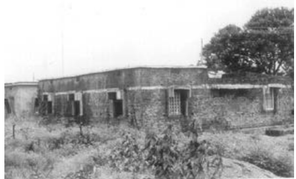
(ख) किल्लरी गाउँमा लिन्टल पट्टी सहितको घर : कुनैपनि क्षति भएन
