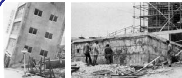
चित्र ३१.३ : जमिनमा दबेका र जमिनमाथी उठेका संरचना- भास्सिएको भवन, जमिनमाथी उठेको शौचालयको दयाङ्गी, सन् १९६४ को निगाहा भूकम्प, जापान
