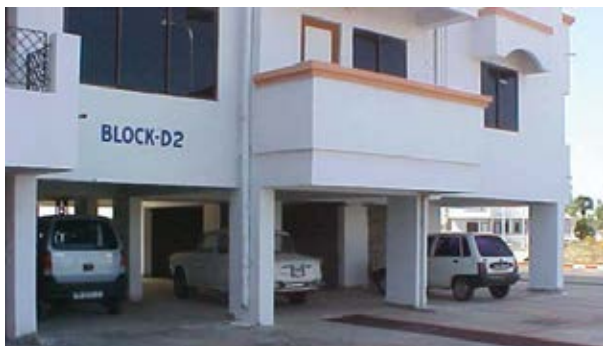
चित्र २१.१ : आरसीसी भवनका भुईँतल्ला पार्किङको लागि खुल्ला छाडिएको । भारतका शहरी क्षेत्रहरूमा सामान्यतया यस्तो गरिन्छ ।
