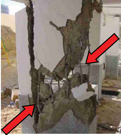
चित्र ८.२: पिलरमा देखिने विकर्ण चिराले भवनको भार बहन क्षमतालाई कमजोर बनाइदिन्छ -अस्वीकार्य क्षति
